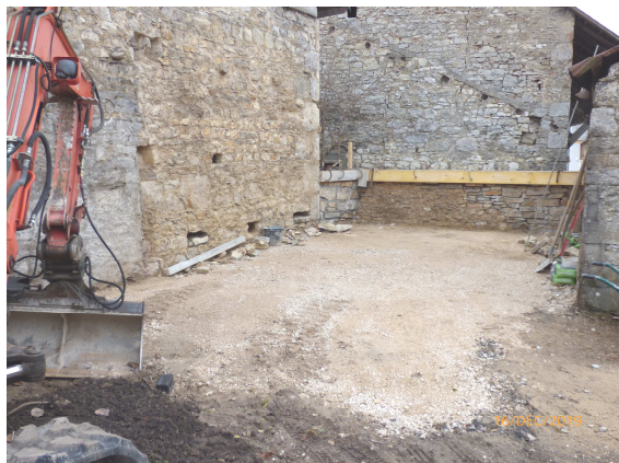
Démolition des appentis aux abords du four du quart d'Avard à Aranc
